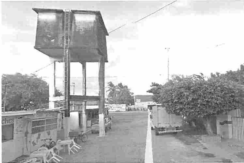
FOTO 02- CAIXA D'ÁGUA A SER DEMOLIDA
